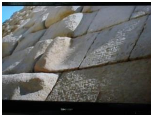
Рис. 13. Следы обработки каменной облицовки
