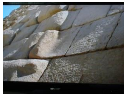
Рис.13. Следы обработки каменной облицовки
